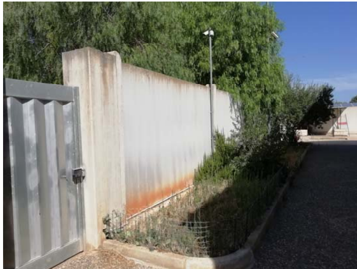
Fig. 1: Muro perimetrale dell'impianto PASQUALE REALE
