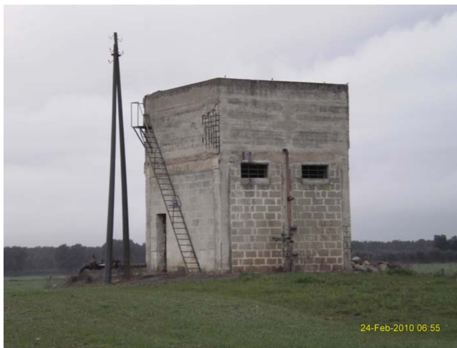
Figura 21: Pozzo profondo presente in prossimità della masseria d’Agnano
