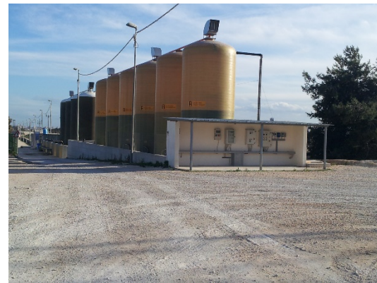
Silos di stoccaggio temporaneo percolato I Lotto (a sx) e II Lotto (a dx)
