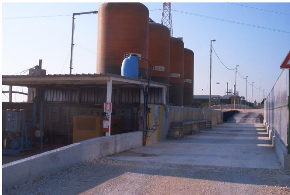
Silos di stoccaggio temporaneo percolato I Lotto (a sx) e II Lotto (a dx)
