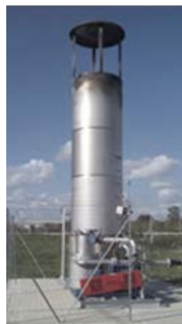
Torcia statica di combustione biogas con piedistallo (a sx) e torcia dinamica da 500 Nmc/h (a dx)
