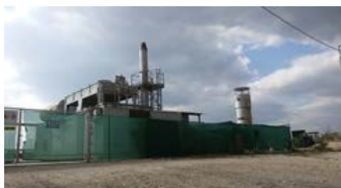
Torcia statica di combustione biogas con piedistallo (a sx) e torcia dinamica da 500 Nmc/h (a dx)
